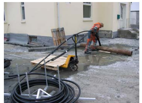
Forlenget til utlegging av 90mm SDR17
