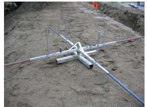
Forlenget til utlegging av 90mm SDR17
